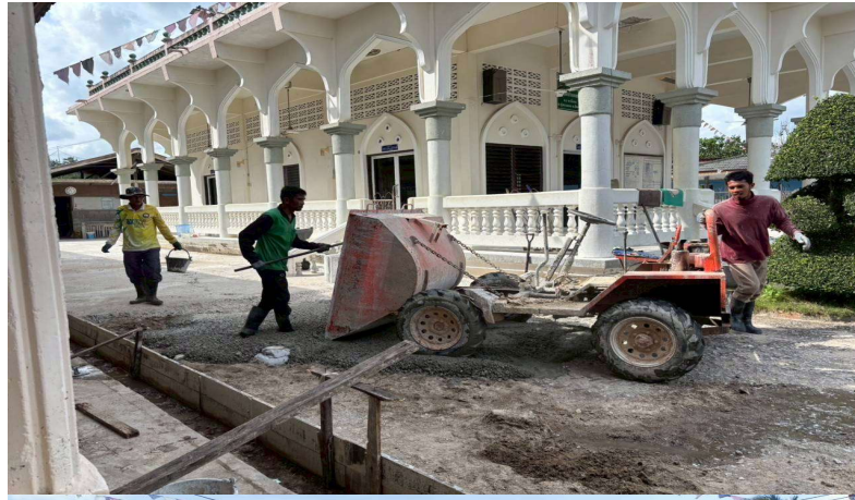
โครงการเทศบาลคอนกรีตรอบบริเวณมัสยิด (ป่ามะพร้าว) หมู่ที่ ๓
