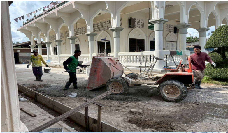
โครงการเทลานคอนกรีตรอบบริเวณมัสยิด (ป่ามะพร้าว) หมู่ที่ ๓
